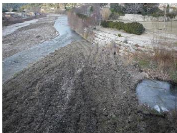
Atterrissement après scarification (février 2012, ouvèze, Vaison, SMOP)
