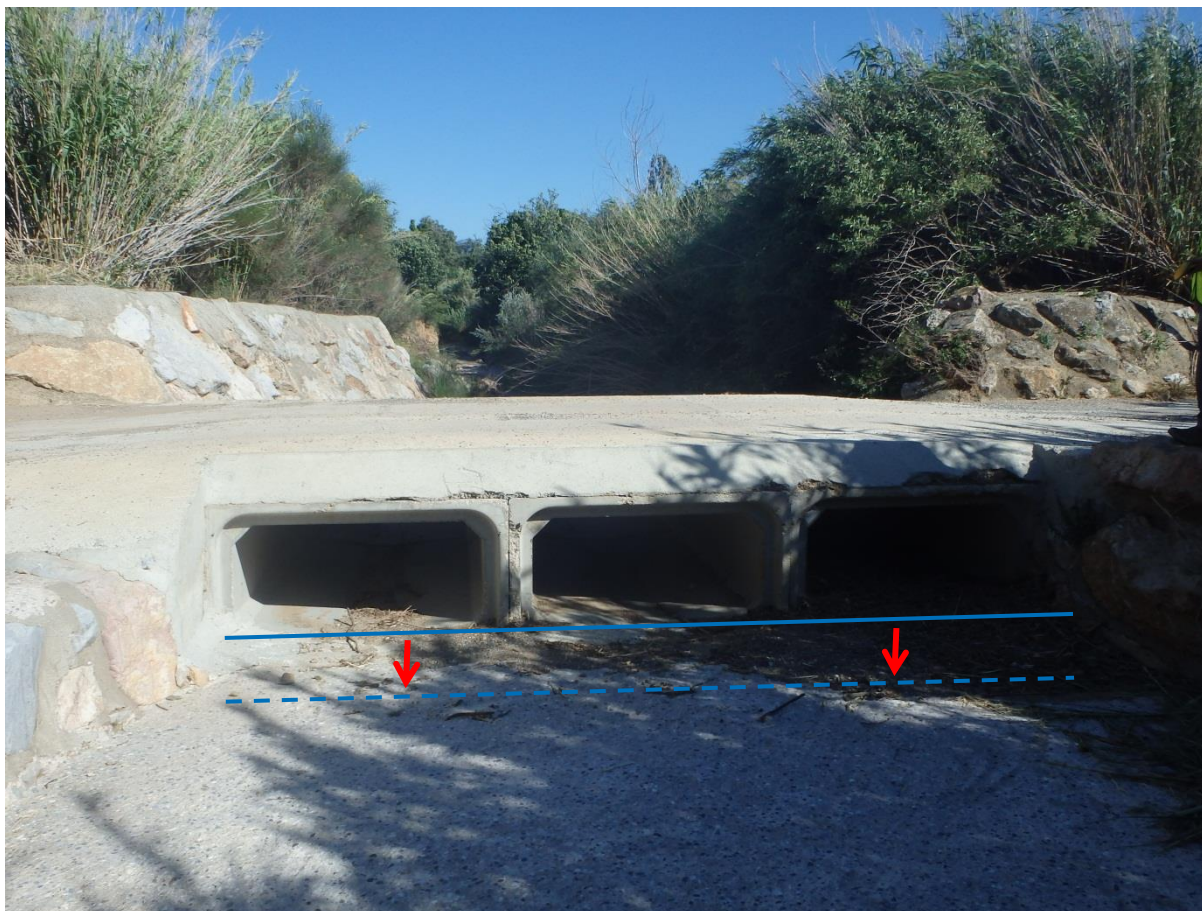
Visualisation du passage à gué avec ses dalots depuis l'amont
